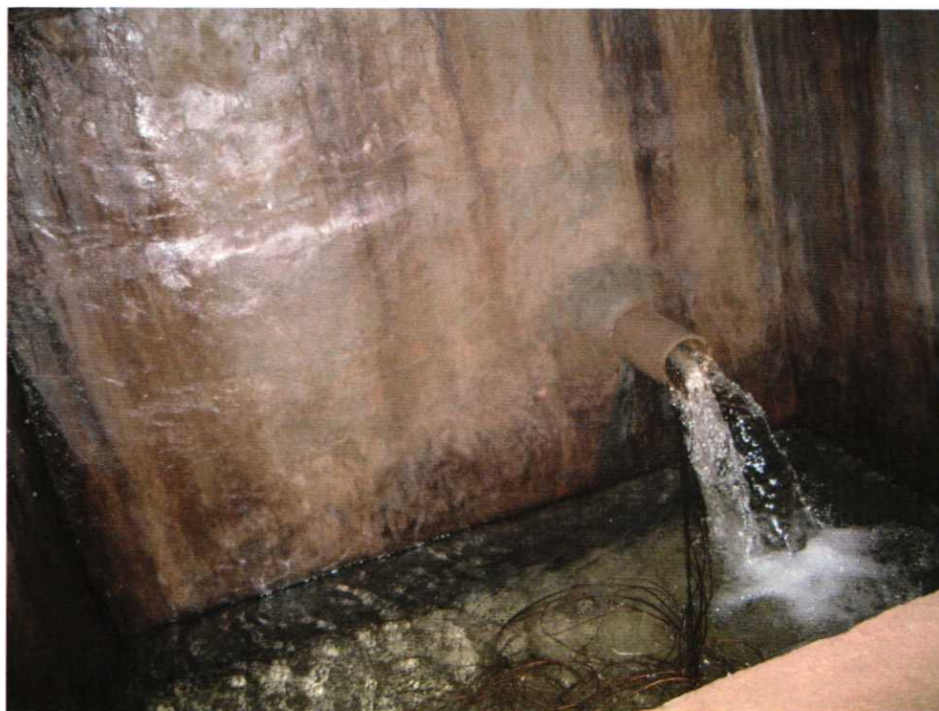
Водната камера на каптажната шахта на извор „Кю бунар” с вливната тръба
