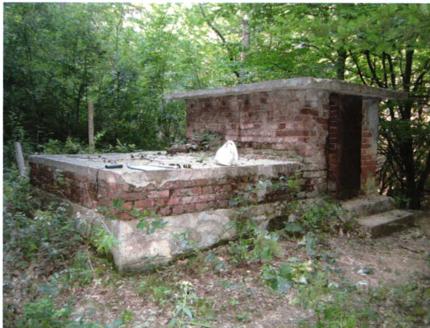
Външен вид на каптажната шахта на извор „Тепегьоза II“
