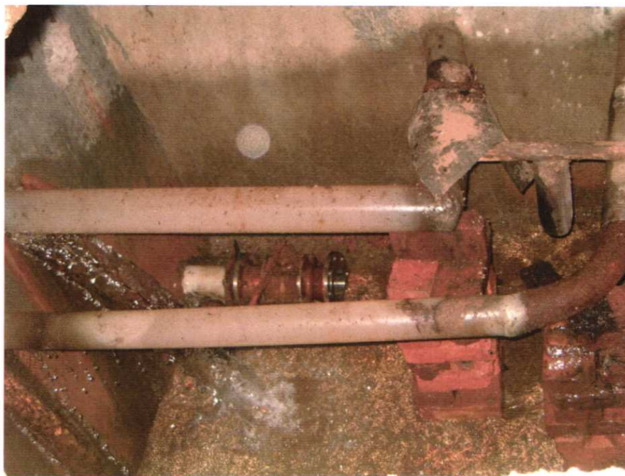
Сухата камера на каптажната шахта, с двете вливни тръби и хранителната тръба
